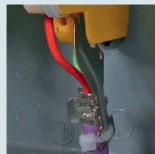
EMV-Federklemme für dauerhafte, niederimpedante Schirmkontaktierung.
