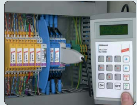
LifeCheck-Sensor mit Aufrastfunktion
