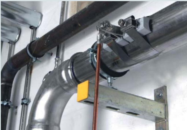
Anwendung an einem NIRO-Rohr
