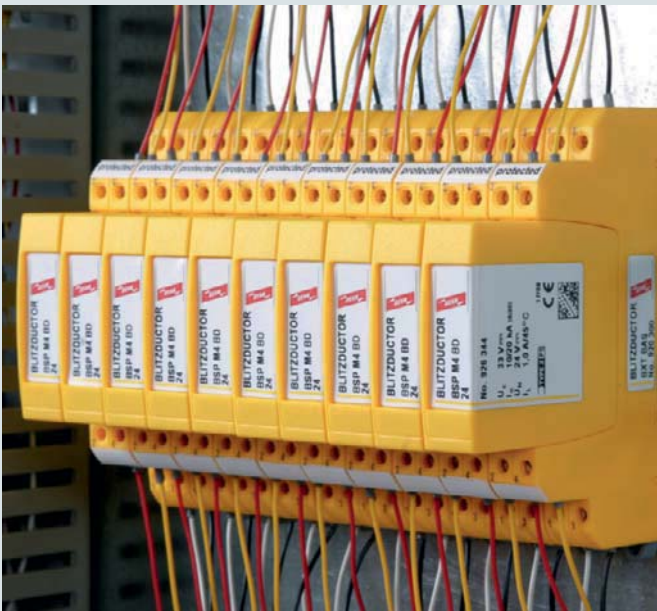
Teilbarer, mehrpoliger, universeller Überspannungs-Ableiter für informationstechnische Systeme.
