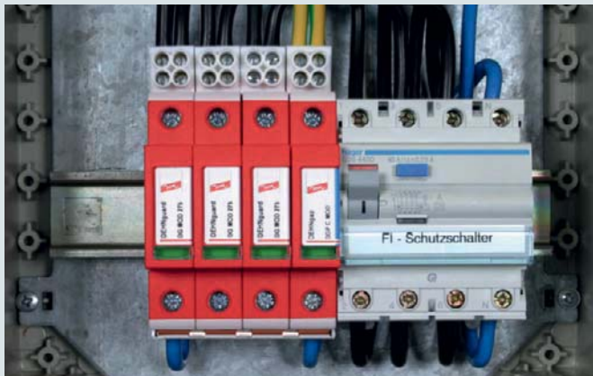
Umsetzung einer EMV-optimalen Durchgangsverdrahtung nach DIN VDE 0100-534 von Blitzstrom- und Überspannungs-Ableitern mittels STAK 2X16.
