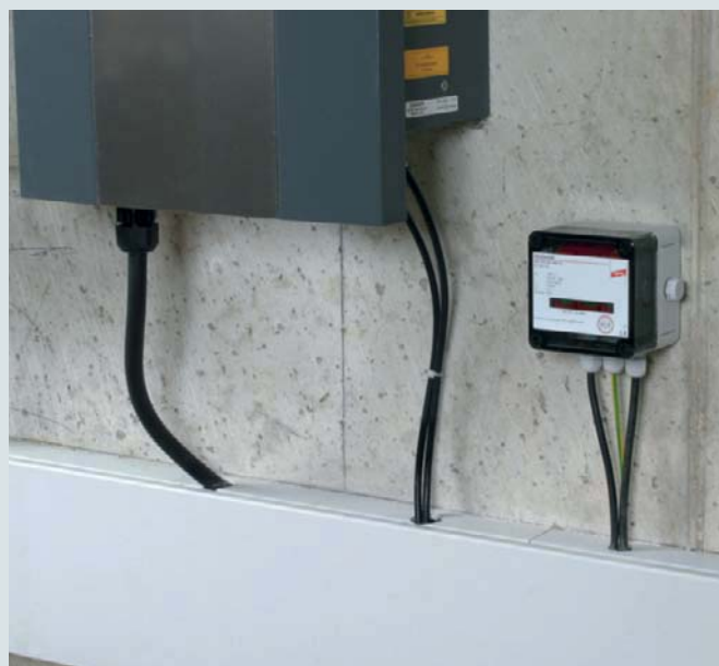
Zum Schutz von Niederspannungs-Verbraucheranlagen vor Überspannungen. Zum Einsatz gemäß IEC 60364-7-712:2002-05 "Errichten von Photovoltaik-Versorgungssystemen".
