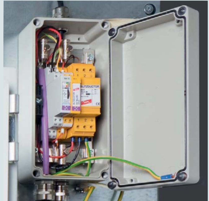
Kompakter Geräteschutz mit Schraubklemmanschlüssen für mehradrige Leitungen zur Hutschienenmontage.
