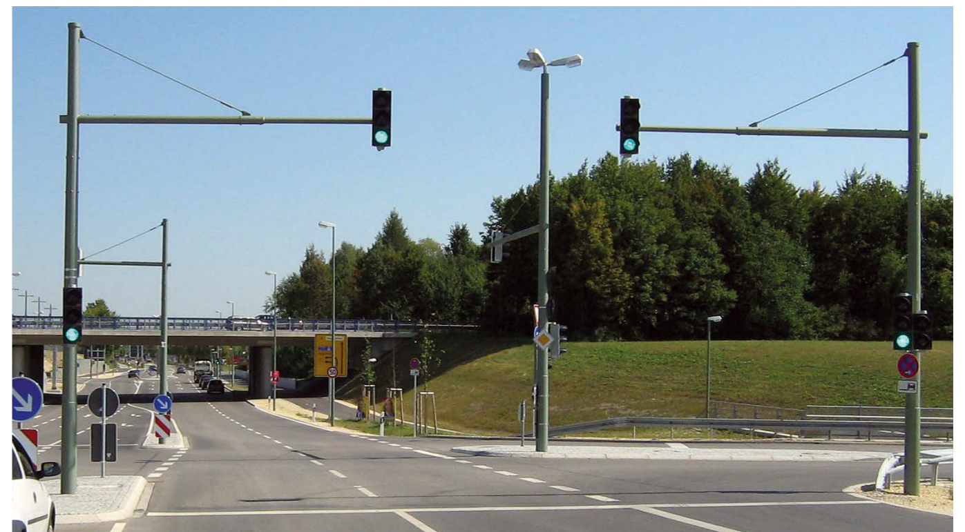
Ampelmast in Augsburg Ausladung von 3 bis 7,5 m – verlängerbar bis 10 m; Ausführung mit drehbarem Ausleger für Sondertransporte
