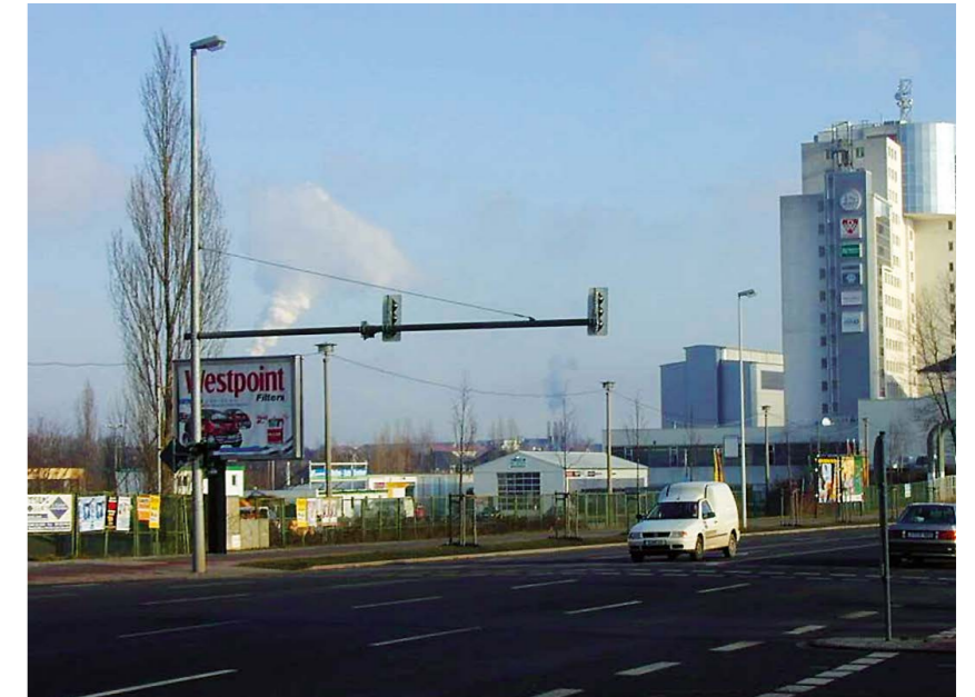
LSA-Mast Typ Leipzig Masthöhe 8,5–12 m; Ausladung 3–12 m, Ausleger abnehmbar
