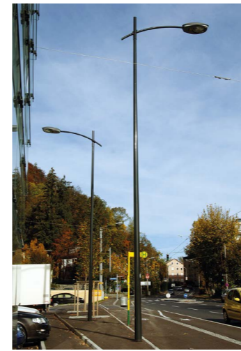
GFK-Dekorlichtmast mit Ausleger in Salzburg, Clemens-Krauss-Straße
