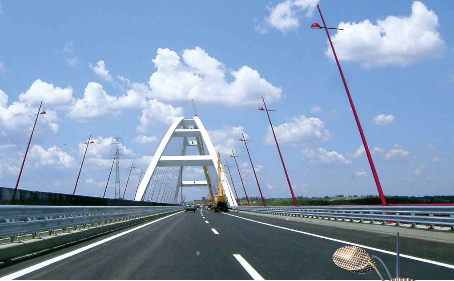
Brücke bei Dunaújváros, Ungarn Masthöhe 13 m; Lichtpunkthöhe 11,5 m; Ausladung: 300 mm; Mastneigung: 16,5°
