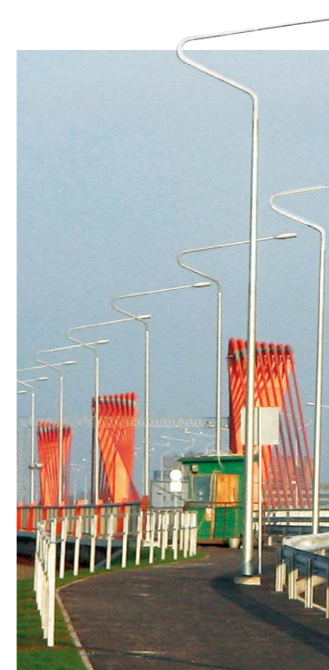
Europabrücke Riga, Lettland Konischer Maststiel mit zylindrischem, doppelt gebogenem, abnehmbarem Ausleger; Lichtpunkthöhe 8 m; Ausladung 1,8 m
