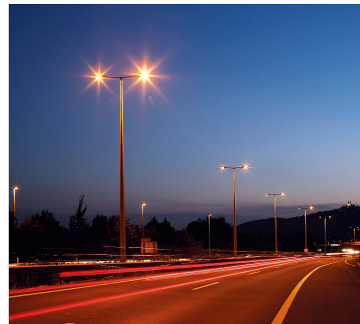
An der A7-Mühlkreisautobahn bei Linz in Österreich wurden die GFK-Masten vor allem wegen der passiven Sicherheit eingesetzt. Die leichte Montage, die durch das geringe Eigengewicht auch am Brückengeländer möglich ist, ist ein weiterer Vorteil.
