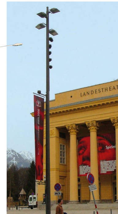
Landestheater Innsbruck, Österreich Flutlichtmast Höhe 15 m Mit Fahnenhissvorrichtung und Magnetpositionierung der Fahne
