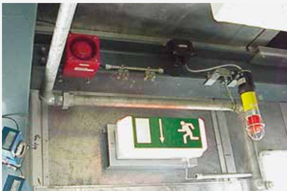
Gasdetektion mit optischer und akustischer Alarmierung: ☁-Schallgeber DS 10 ATEX und ☁-Blitzleuchte CWB-ATEX.
