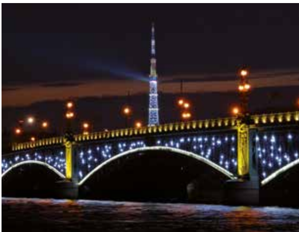
St. Petersburg, Russland Fernsehturm und Dreifaltigkeitsbrücke 9.500 Pfannenberg Blitzleuchten
