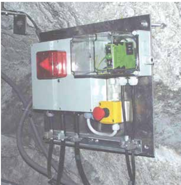
Abb.: die Kompakt-Blitzleuchte PY X-S-05 im Tunnelleinsatz, Eingangsspannungsbereich: 70–264 V AC / 73–140 V DC (Netz/Batterie)
