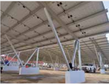
Ortbeton-Fundamentierung
