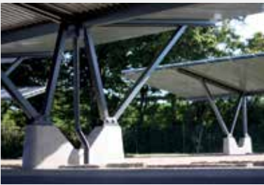
Mikropfahl-Fundamentierung
