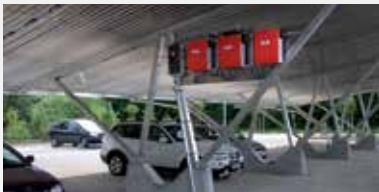
Wechselrichterbefestigung
