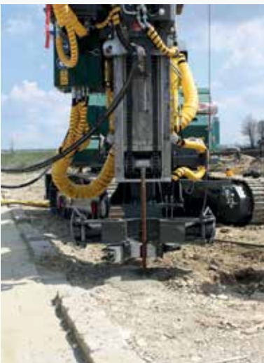
Bohrung für Mikropfahl-Fundamentierung
