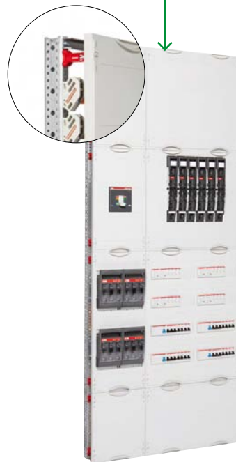
Einbau WR-Montagegerüst Ausbau als Installationsverteiler mit CombiLine Modulen auf WR-Montagegerüst
