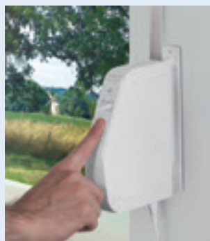
Gurtband einziehen und Schwenkwickler einrasten
