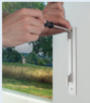
Wandhalterung montieren
