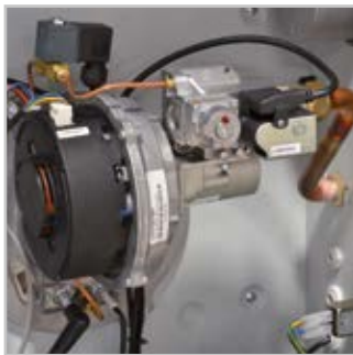
Hohe Energieeffizienz durch modulierenden Gasbrenner
