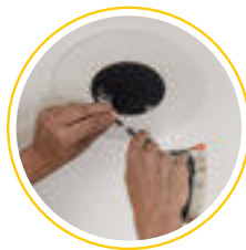
5. Elektrischer Anschluss und Installation der neuen Deckeneinbauleuchte.
