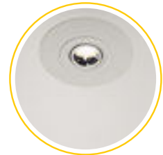
6. Neue Deckeneinbauleuchte in Reduzierring platziert.
