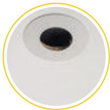
4. Reduzierring eingebaut. Größerer Deckenausschnitt gänzlich abgedeckt.
