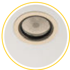
1. Alte Deckeneinbauleuchte mit größerem Deckenausschnitt.
