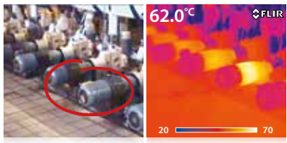
Mechanische Überprüfung eines Elektromotors.
