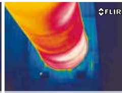
Zusammenbruch der feuerfesten Auskleidung eines Drehrohrofens
