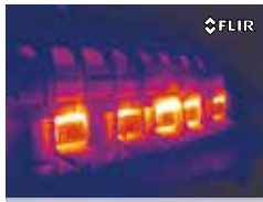
Defekt der feuerfesten Auskleidung
